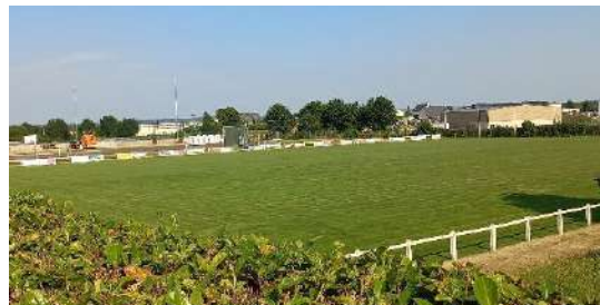
Pôle sportif et ses vestiaires en rénovation
