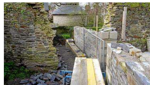
Travaux de création des chemins de ronde
