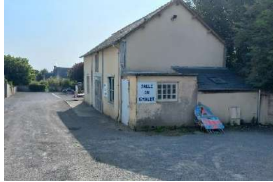
Ses salles de quartier à rénover...
