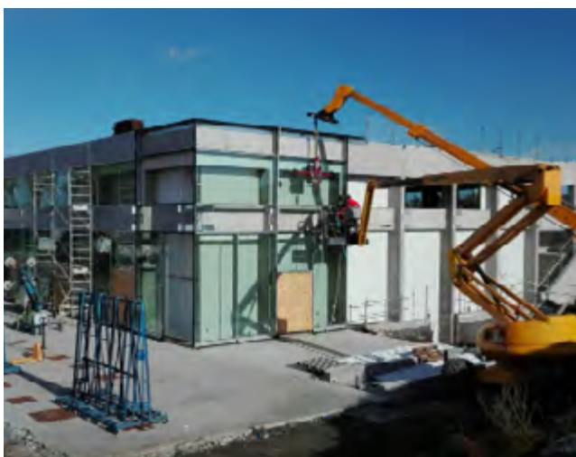
Sur les façades ouest et sud de la future piscine, la pose des menuiseries aluminium par la société CMA. Au premier plan, sur la dalle béton, l'emplacement du Splashpad extérieur (jeux d'eau). La mise en œuvre des éléments en inox revêtu s'achève pour le bassin ludique, ainsi que les accès (escalier et rampe PMR).
