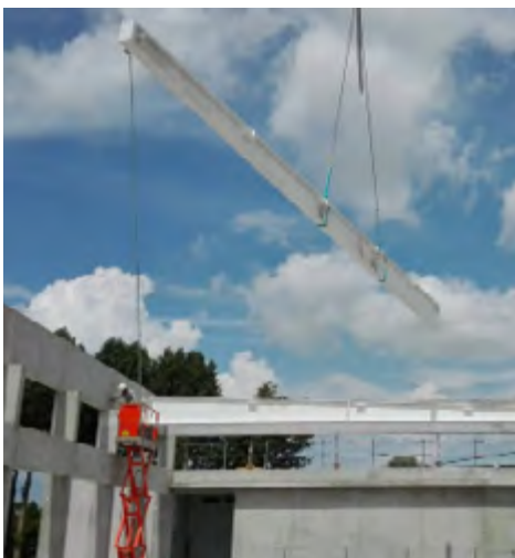
Les premiers éléments arrivent...La charpente de la halle bassin sera montée par l'entreprise OMS et son sous-traitant.
