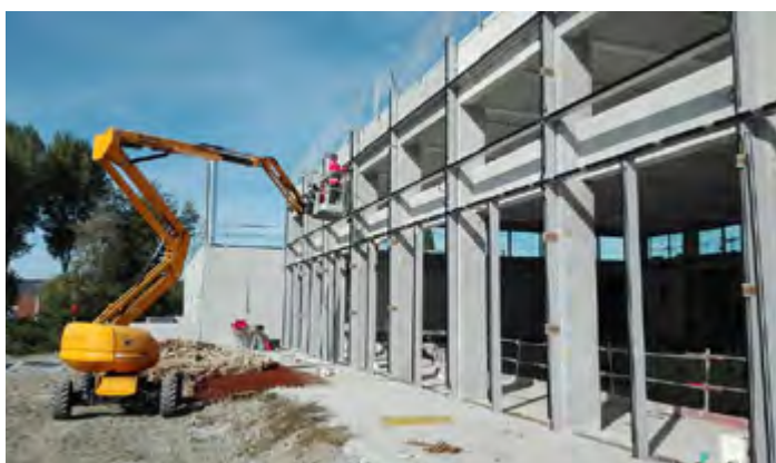
Pose du "mur rideau" sur la façade Ouest de la piscine. Les vitrages seront installés la semaine suivante par l'entreprise CMA.
