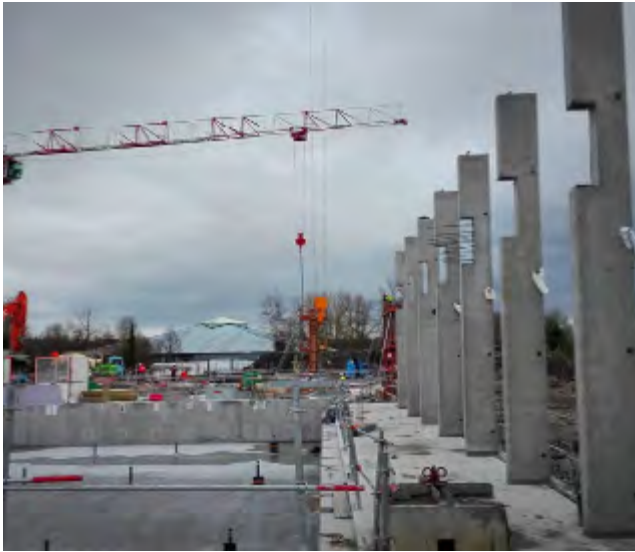
Les premières élévations du rez-de-chaussée apparaissent
