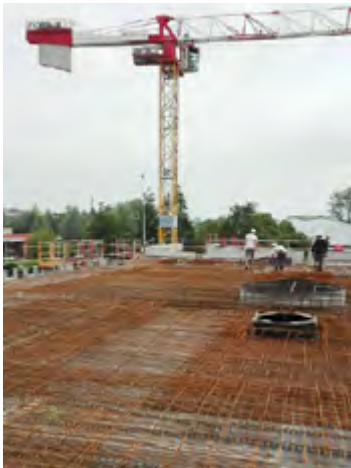
Préparation du coulage de la dalle haute du rez-de-chaussée.
