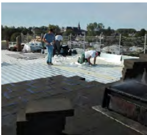
Mise en œuvre de l'isolant de toiture.
