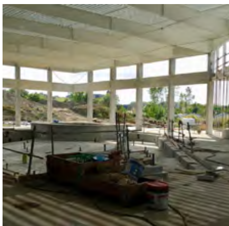
Encore quelques semaines avant que le bâtiment soit hors d'eau et hors d'air. À ce moment pourra alors commencer l'installation des bassins inox.
