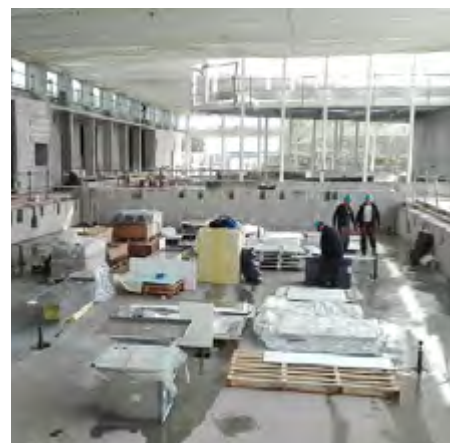
Le bassin en inox de la marque "Myrtha Pools" est arrivé. La mise en œuvre commence pour le bassin sportif.
