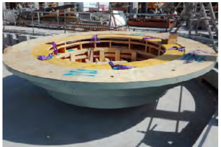
Le coffrage du jacuzzi est en place dans le bassin ludique. Il est réalisé sur mesure par EIFFAGE pour le projet.
