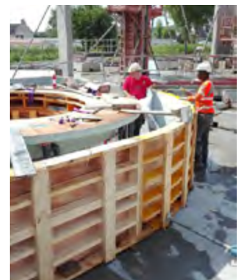
Réalisation des coffrages intérieur et extérieur du SPA
