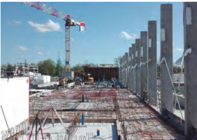
30 personnes sur le chantier ; le rez-de-chaussée, hors halle bassin, avance vite !
