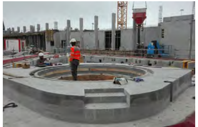
Le jacuzzi en cours de décoffrage, il aura fallu 28m 3 de béton pour le couler.
