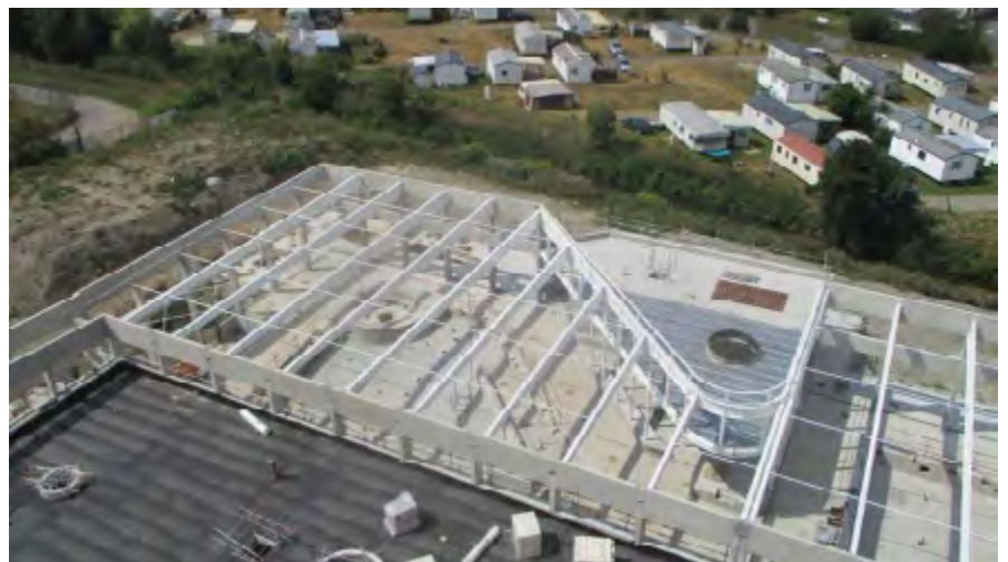
Petit à petit la future piscine se couvre de sa charpente métallique.
