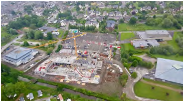
Vue aérienne du chantier. Dans quelques temps apparaîtront les contours de la rivière sauvage.
