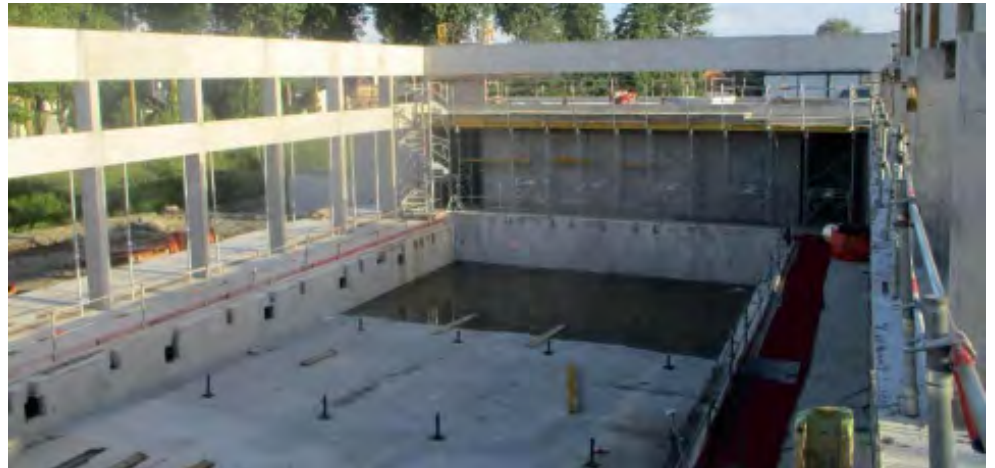
Le volume intérieur de la hall "bassins" commence à bien se distinguer en attendant la pose de la charpente.
