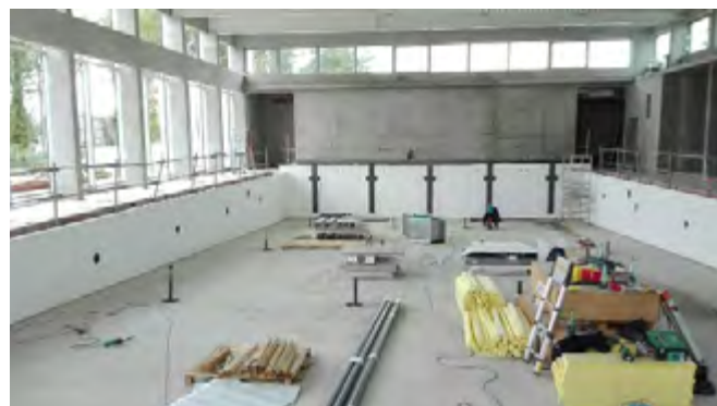
Les parois verticales du bassin sportif en inox revêtu sont achevées.
